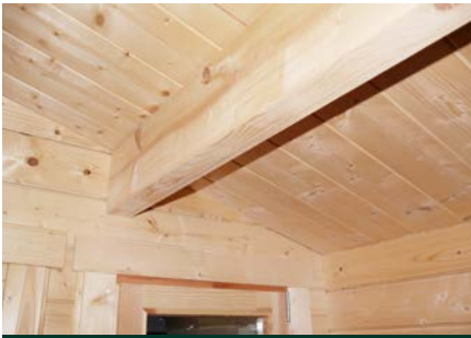
Dachpfetten 70 x 180 mm
