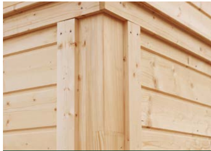
Umlaufende Leimholzkonstruktion
