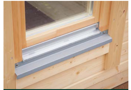
Fenster mit Metall-Fensterbank
