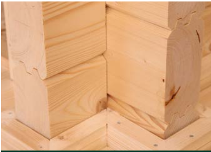
Eckverbindung 70-mm-Bohle
