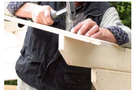
Abgeschrägte Seitenwandbohle
