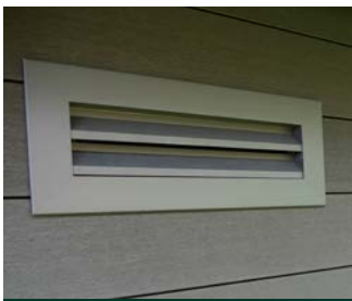
2 Aluminium Lüftungselemente in der Seitenwand
