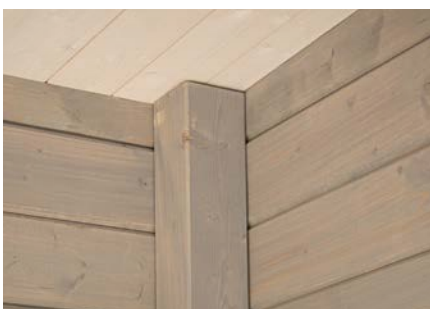
Eckpfosten aus Leimholz 90 x 90 mm
