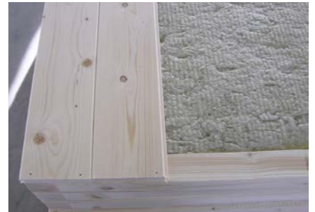
Gedämmte Zwischendecke im Saunaraum
